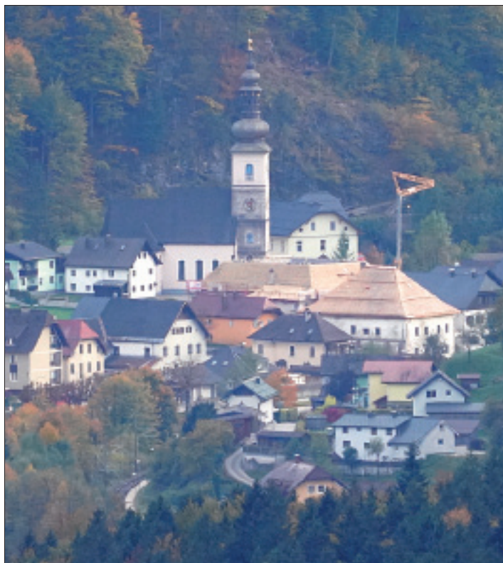
Vier Häuser im Ortskern von Lauffen erhalten Lärchenschindel-Dächer. Es werden 2400 Quadratmeter gedeckt.
