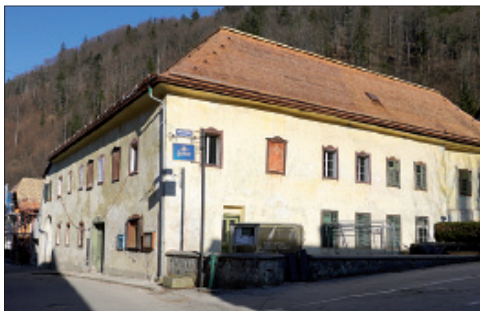
Eines der zentralen Gebäude von Lauffen ist das sogenannte „Armenhaus“, das der Gemeinde Bad Ischl gehörte. Es wird, wie drei weitere Gebäude im Ortszentrum, saniert und soll in die Kulturhauptstadt 2024 eingebunden werden.
